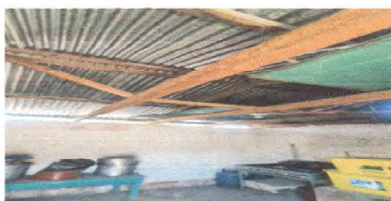
Foto 5: Sustitucion de soporte de madera por metal
