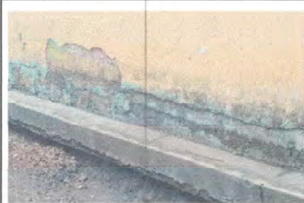
Foto 8: Reparacion de repello y cernido de pared
