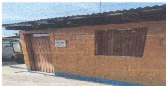
Foto 4: sustitucion de puerta y ventana.
