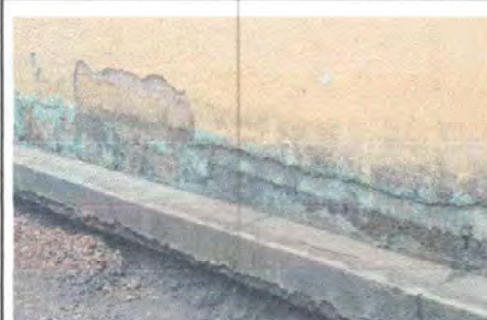
Foto 8: Reparacion de repello y cernido de pared
