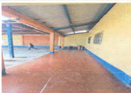
Foto 7: Reparacion de repello cernido de pared
