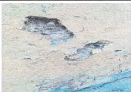
Foto 11: Reparacion de cernido y repello de pared
