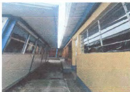
Foto 11: Reparacion de canales y bajadas de agua
