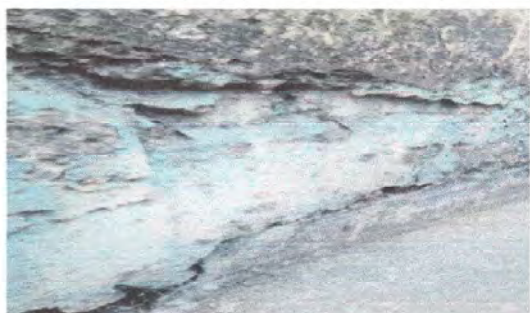
Foto1: Reparacion de repello y cernido.
