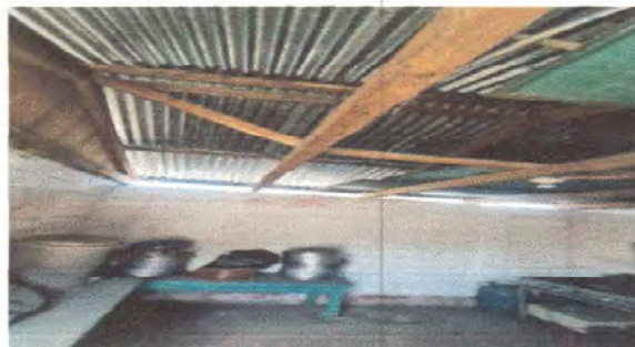
Foto 2: Sustitución de lámina, por lámina troquelada aluzincn calibre 26 en cocina
