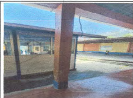
Foto 12: Reparacion de cernido y repello
